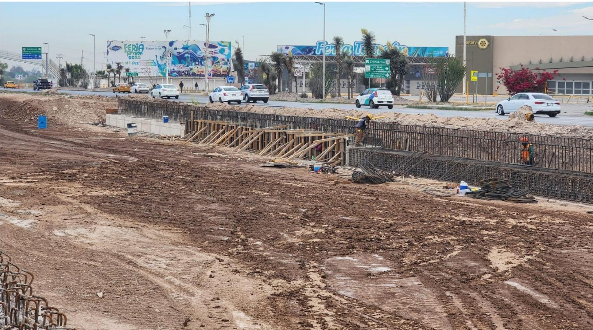
Armado de acero de refuerzo para cabezal
